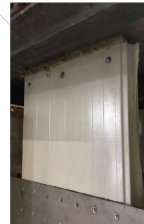
Stud bolts test
